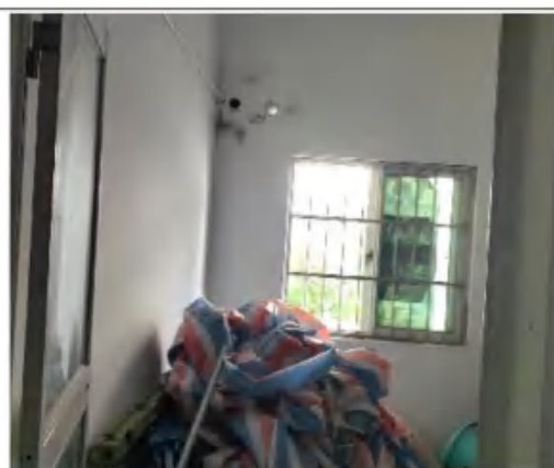
拟建废物存储间（清洁间）
