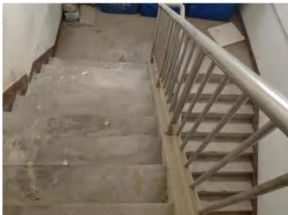
项目所在楼层东侧楼道
