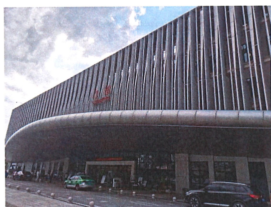
图 1-4 南侧 1 号门诊大楼
