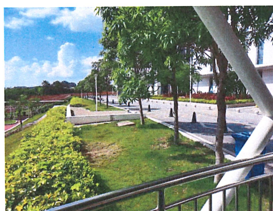
图 1-5 西侧绿化空地及院内道路
